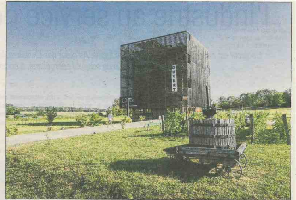
La Caborde, un bâtiment qui divise au sein de la communauté de communes Porte du Jura.
